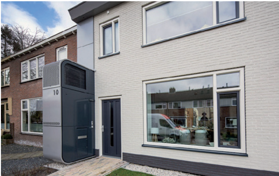
Figuur 18: NOM-renovatie in Gorredijk
