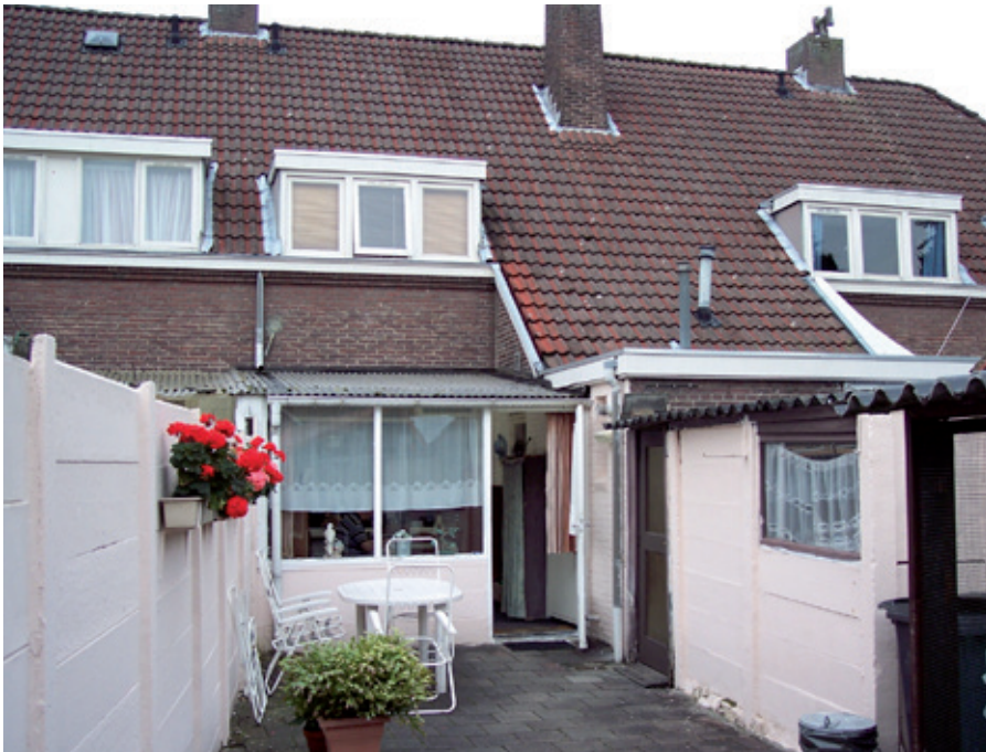
Figuur 22: Voorbeeld van identiek gebouwde woningen, maar met grote variëteit in voorzieningen aan de achterzijde
